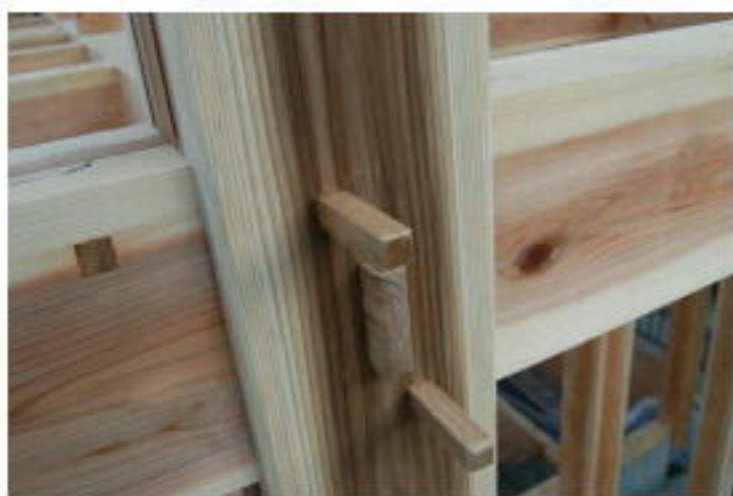
写真上／構造材には釘を使わずに、コミ栓を使うことで、解体・再生がしやすいようにしている。写真下／2階図書室の入り口。建具にはアクセントとしてステンドグラスをはめ込んでいる。
