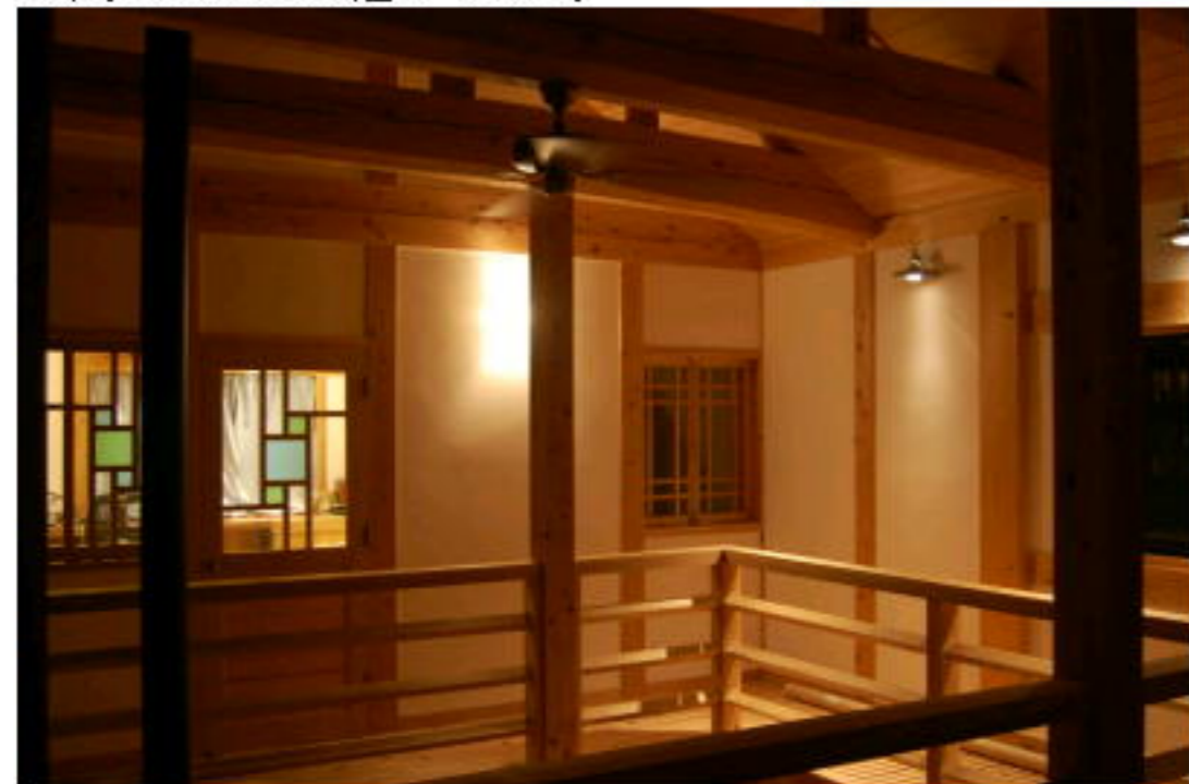
写真上／構造材には釘を使わずに、コミ栓を使うことで、解体・再生がしやすいようにしている。写真下／2階図書室の入り口。建具にはアクセントとしてステンドグラスをはめ込んでいる。
