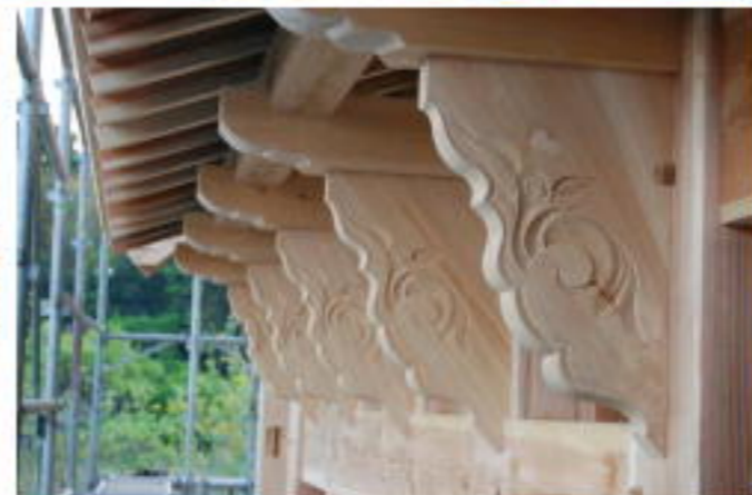
写真上／大工さんが刻んだ、軒を支える肘木に彫られた飾り。写真右下／黄昏時の和水の家の外観。外壁、内壁は漆喰壁仕上げ。写真下／土間に使う梁。構造材は全て手刻み加工。
