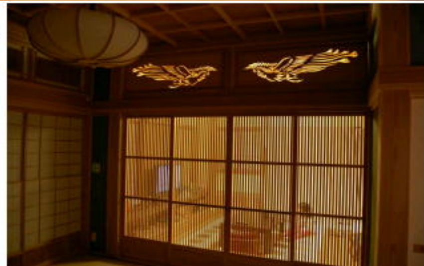
写真上／大工さん特製の座敷欄間のつがいの鳳凰。松の板に透かし彫りで作成してある。写真下／座敷の格天井。伊勢神宮境内にあった杉から作成。
