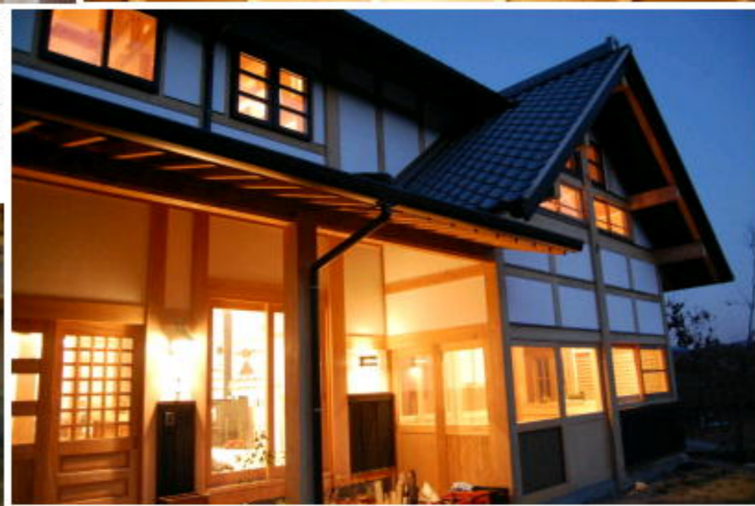
写真上／大工さんが刻んだ、軒を支える肘木に彫られた飾り。写真右下／黄昏時の和水の家の外観。外壁、内壁は漆喰壁仕上げ。写真下／土間に使う梁。構造材は全て手刻み加工。
