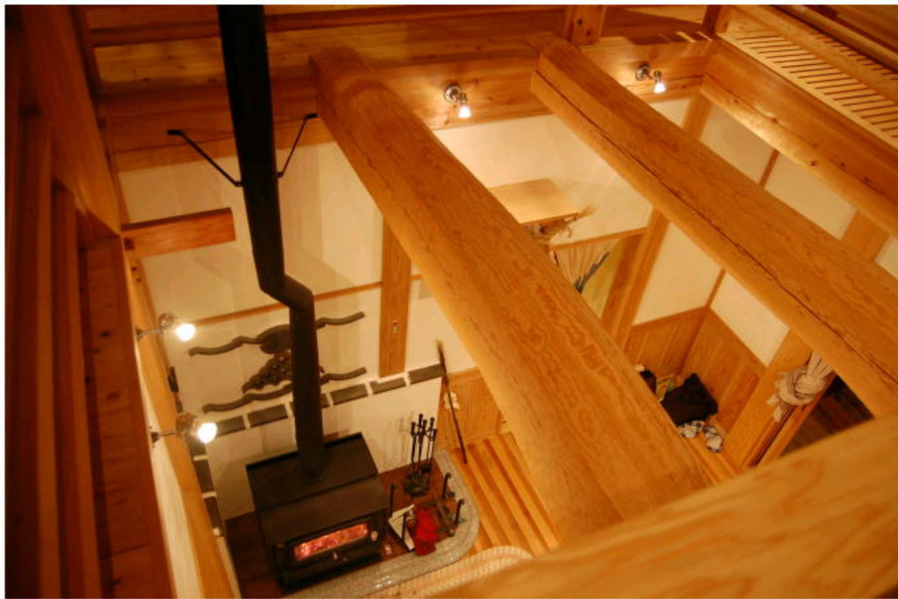
写真左／土間に据え付けてある大工さん特製の囲炉裏（樺・桐置）。壁は錯壁。写真右上／2階吹き抜けから見下ろした1階の薪ストーブ。梁は木目の美しさを引き出す手斧（ちょうな）仕上げ。写真下／座敷の様子。
